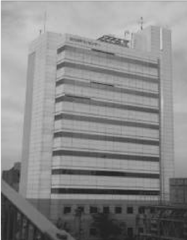
テクノセンタービル
