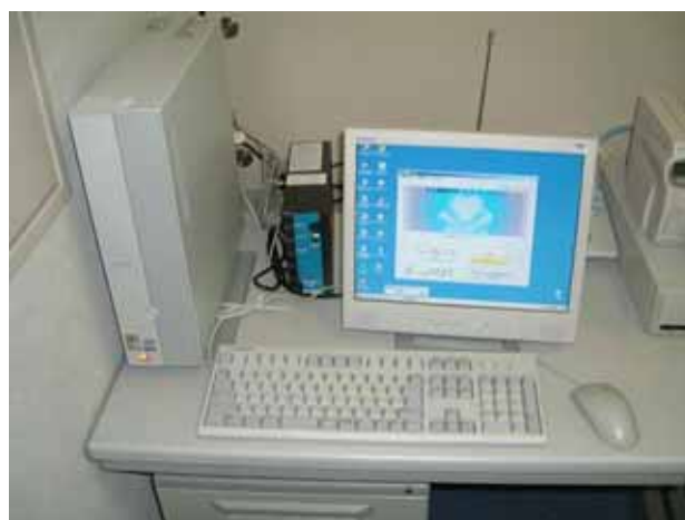
図 3.2.2-4 管理サーバの設置概観
