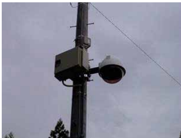
図 2.2.2-3 カメラ設置写真 (カメラハウジング)
