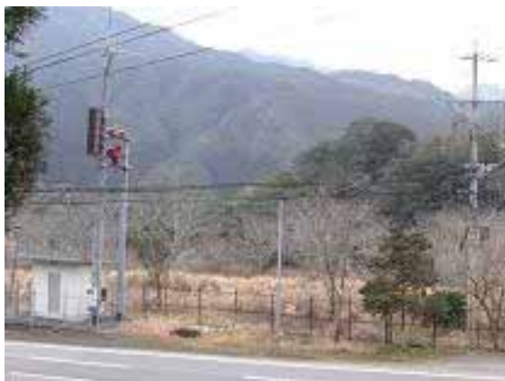
(左) 町の中央を流れる小丸川の対岸の一軒家からサービス申込みがあったため、河川横断のためにリモコン飛行機を使って光ファイバケーブルを敷設（写真手前から山向こうまで）
