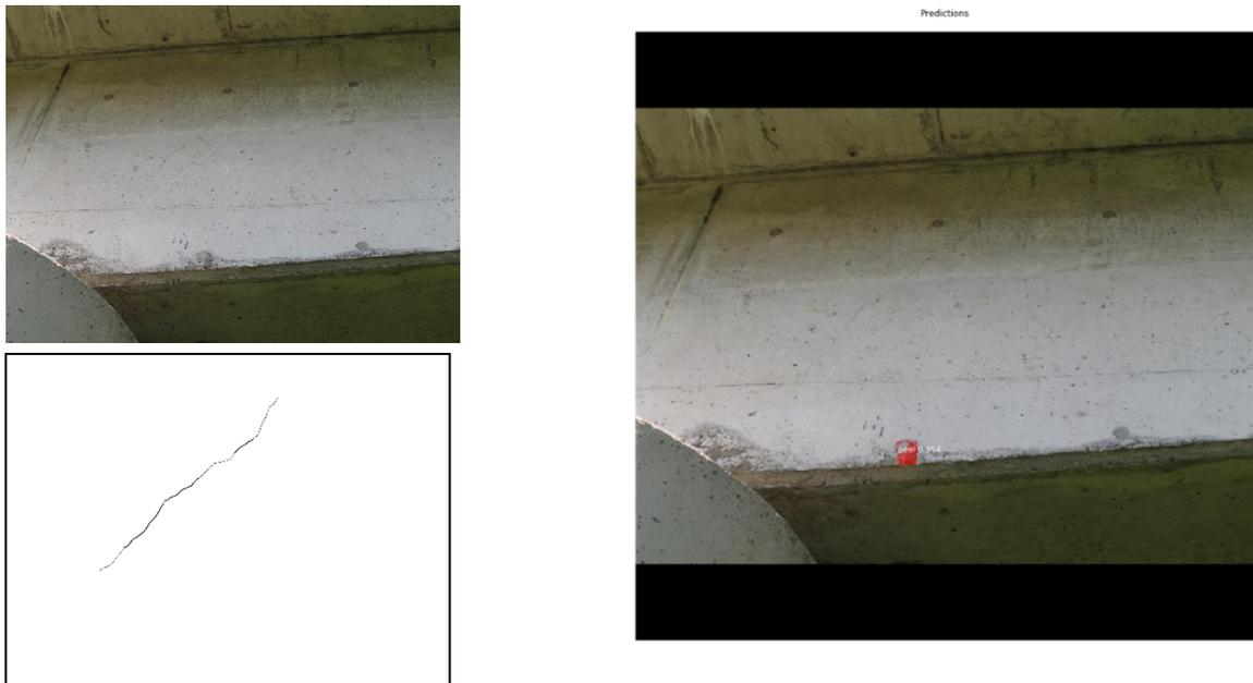
図 48 入力画像と正解ラベル（ひびわれ）（左列）と識別結果（剥落）（右）
